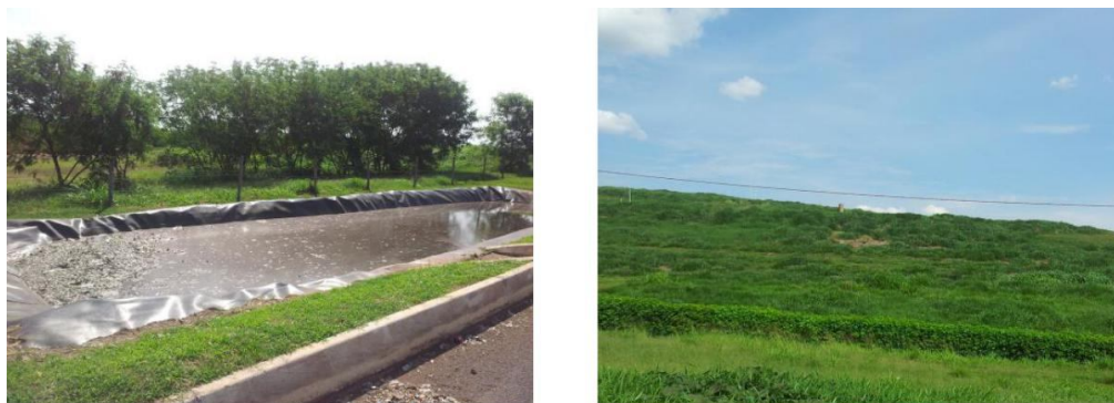
Figura 12 Lagoa de chorume e de efluentes e aterro desativado na área da Usina
