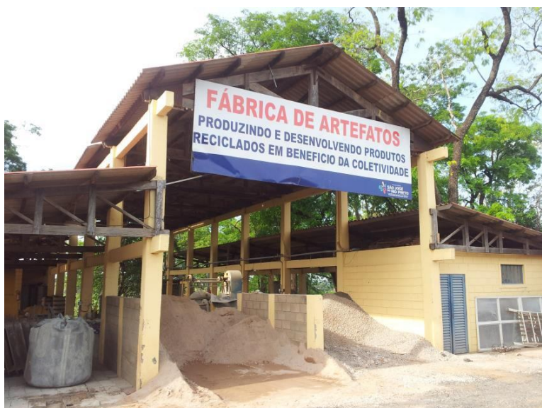
Figura 23 Vista geral da Usina de Artefatos
