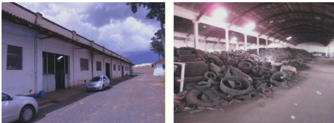
Figura 27 Vista do galpão utilizado pela Cooperativa Cooperlagos e o local de armazenamento de Pneus
