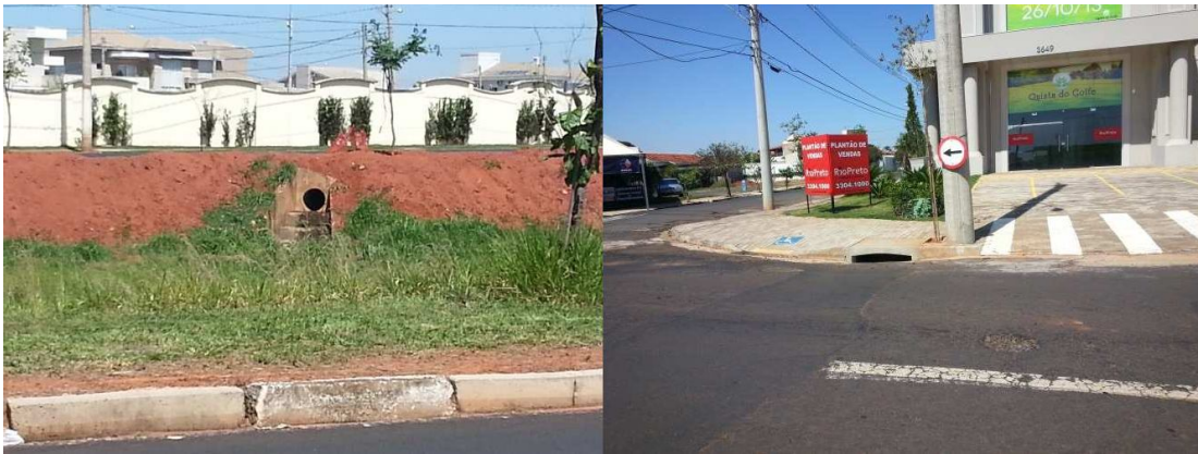
Figura 37 Sistema de drenagem do loteamento com desague nas piscininhas. Figura 38 Vista de boca de lobo na Avenida Presidente Juscelino Kubitschek.
