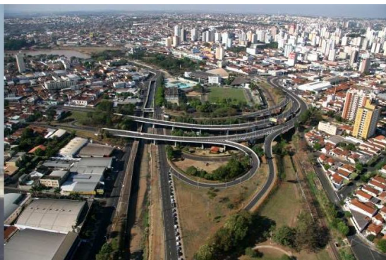
Figura 77 Vista do Viaduto Jordão Reis – a direita ferrovia.
