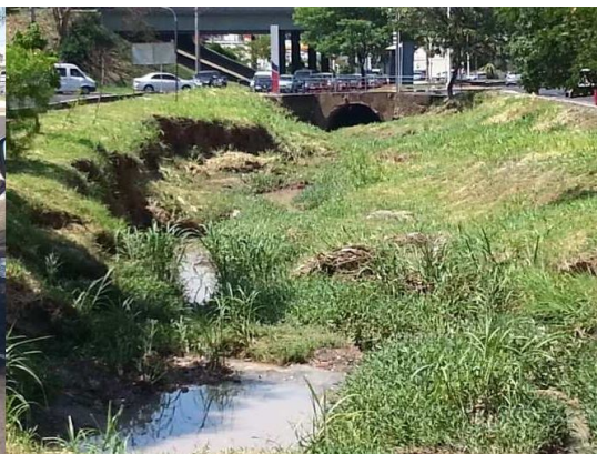
Figura 23 Córrego Borá – vista do início do trecho em seção fechada.
