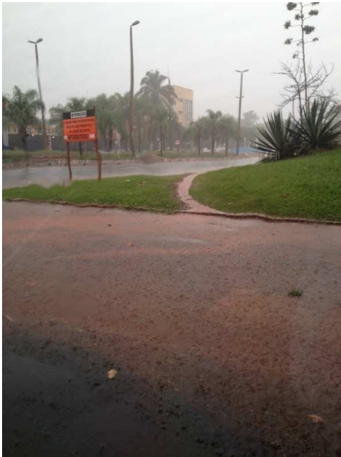
Figura 70 Escoamento disperso sobre o pavimento.
