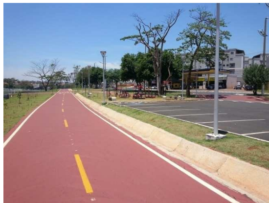
Figura 17 Parque linear no trecho canalizado do rio Preto.
