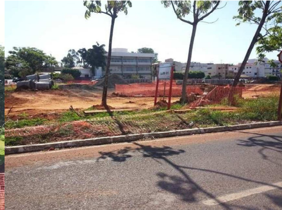
Figura 21 – Trecho em obras na bacia do córrego Canela.
