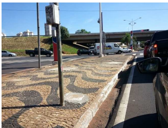
Figura 18 – Córrego Canela – trecho em seção fechada – Avenida Alberto Andalo.
