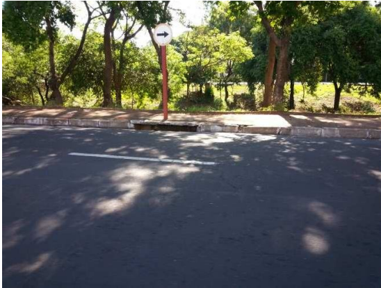
Figura 41 Vista da boca de lobo com lançamento no córrego Aterradinho – Av. Murchid Homsí.
