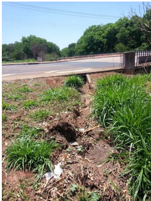
Figura 44 – Vista posterior da boca de lobo com lançamento no rio Preto.
