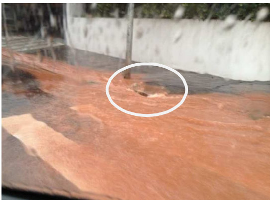
Figura 68 Consequências da falta de estruturas adequadas de microdrenagem.
