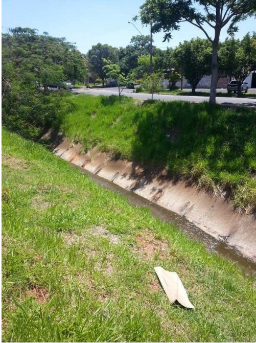
Figura 30 Córrego sem denominação Rua Dr. Antônio T. P. Lima.
