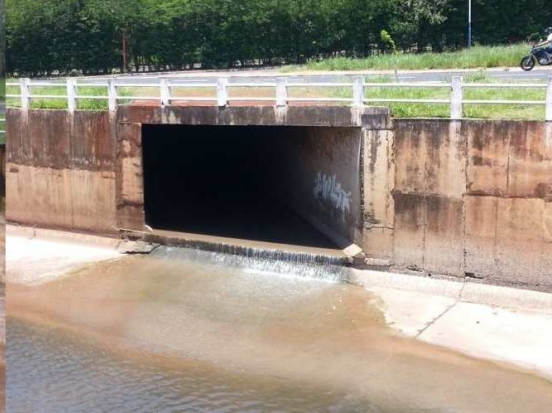
Figura 63 Foz do córrego Borá no rio Preto – sem chuva.
