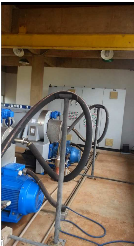
Figura 144 Vista das centrífugas de 60CV, painéis de acionamento e controle, tubulações aparentes no piso e pouco espaço na parte posterior para manutenção
