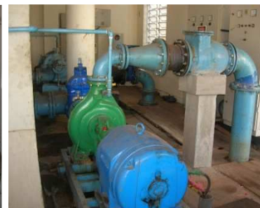
Figura 99 Conjuntos moto-bombas e acionamentos do sistema de recalque de água tratada da ETA
