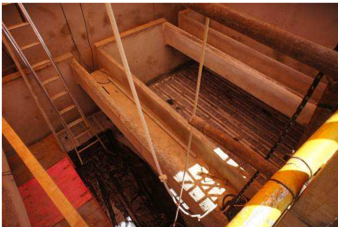
Figura 47 Vista geral de uma unidade de filtração em reforma na ETA Palácio das Águas
