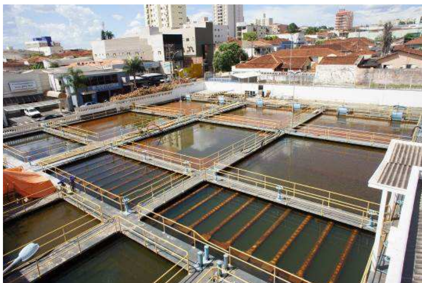
Figura 39 Vista geral dos decantadores
