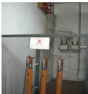
Disjuntor com relés primário e TP's
