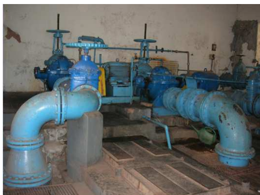
Figura 90 Conjuntos moto bombas da captação da ETA
