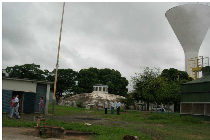
Figura 120 Vista Geral do CRD Urano com PTB em primeiro plano, cabine, reservatórios e torre de resfriamento
