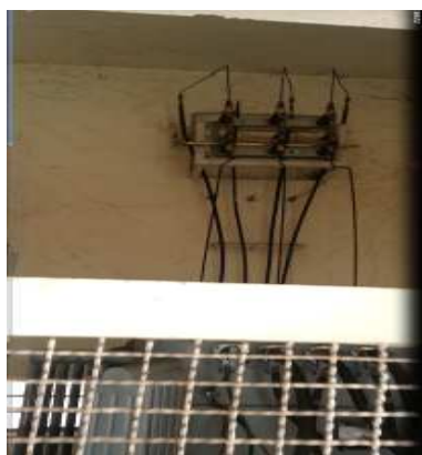
Figura 88 Chave fusível e alimentação do transformador
