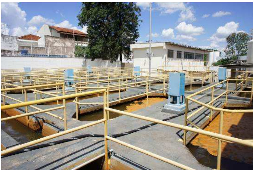
Figura 37 Vista geral do sistema de floculação
