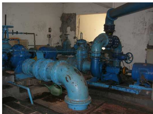
Figura 90 Conjuntos moto bombas da captação da ETA
