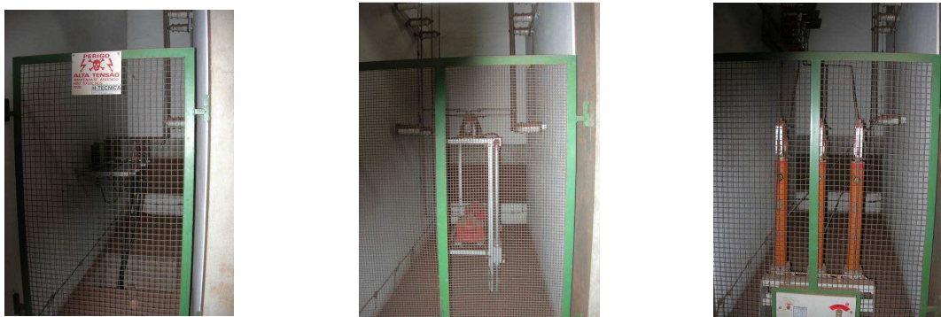
Figura 119 Sequência de fotos da subestação. Cella do disjuntor sem TP's
