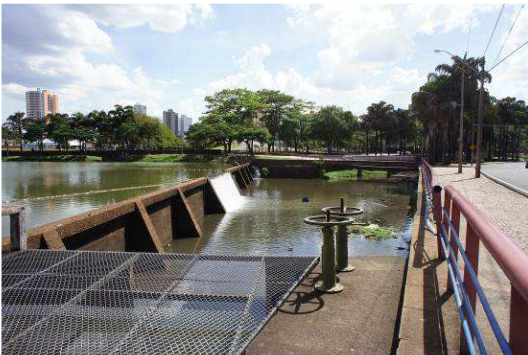
Figura 18 Captação 2 - ETA Palácio das Águas
