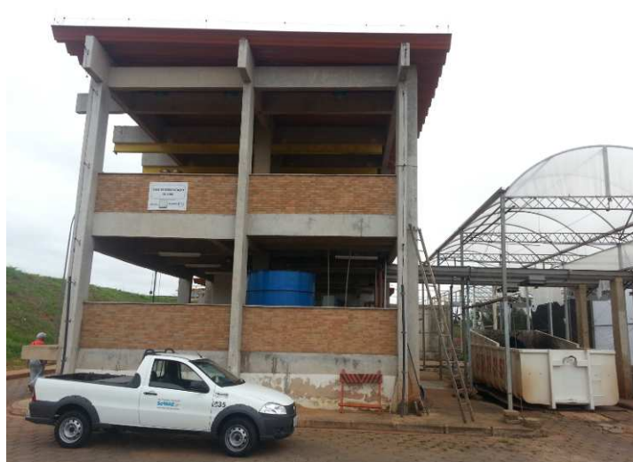
Figura 143 Vista do edifício de desidratação do lodo
