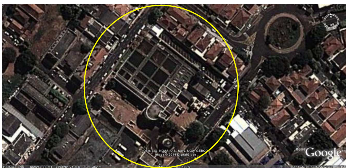
Figura 16 Destaque da localização da ETA – (Fonte: Google Earth - 2014)
