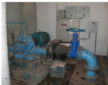
Maceno - Motores de 250 CV- 440Vca e caixa de ligação/fiação
