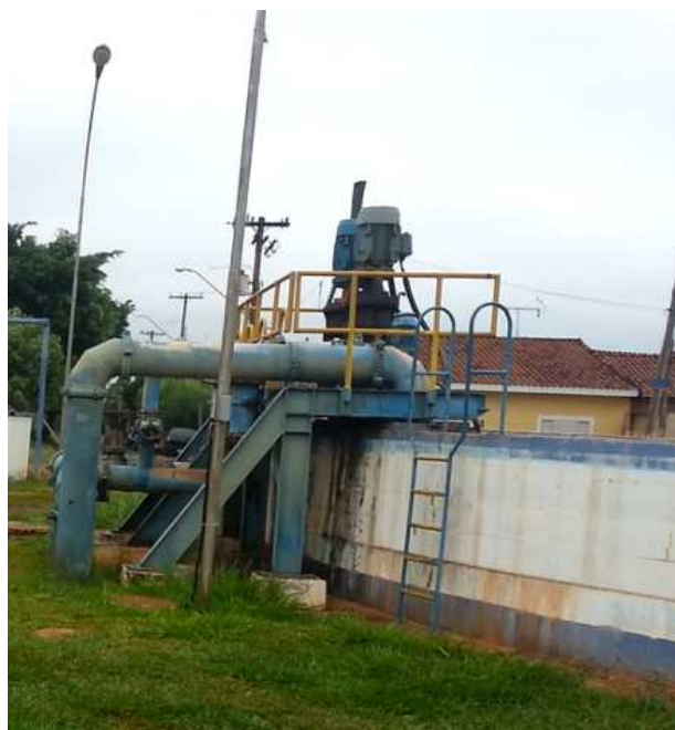
Figura 116 Cjs de 75 CV para Solo Sagrado
