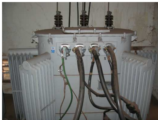
Figura 88 Chave fusível e alimentação do transformador
