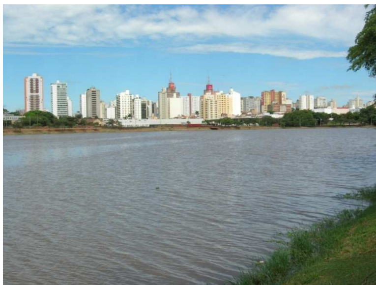
Figura 14 Vista geral do manancial utilizado para a captação de água - ETA Palácio das Águas, localizada próxima ao centro da cidade
