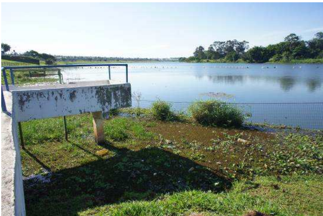
Figura 17 Captação 1 - ETA Palácio das Águas
