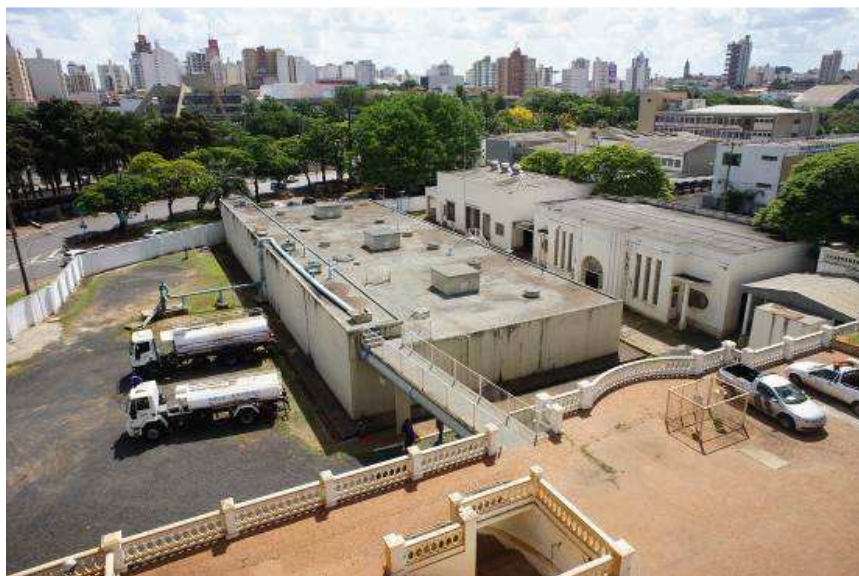
Figura 43 Reservatório de água tratada
