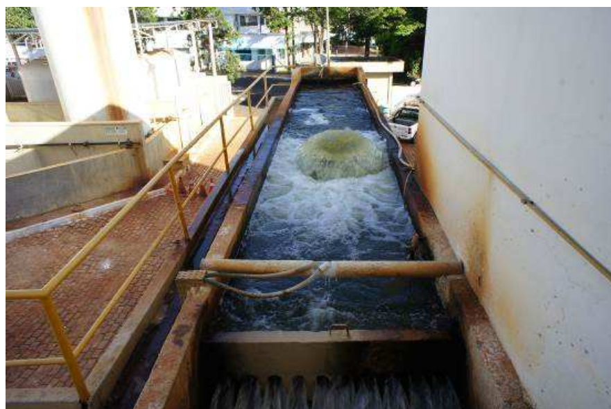
Figura 30 Vista geral do canal de água bruta
