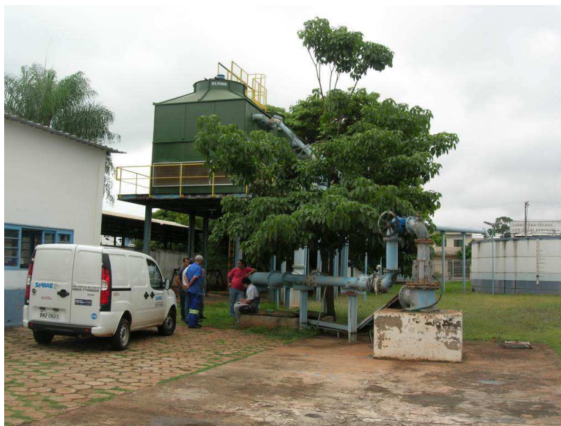
Figura 127 Vista PTG, Torre de Resfriamento e Reservatório Semienterrado
