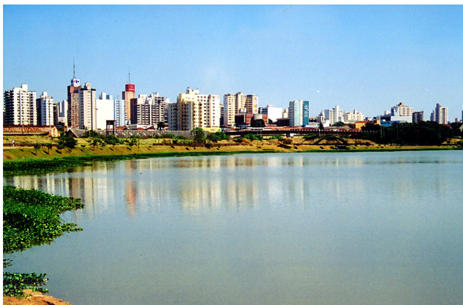
Foto 5 – Vista Geral do Manancial Utilizado para a Captação de Água - ETA Palácio das Águas, Localizada próxima ao Centro da Cidade (reservatório assoreado e com vegetação aquática)
